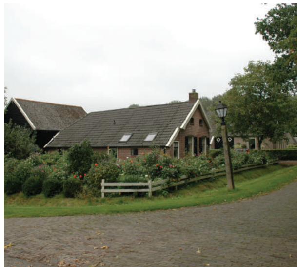
De huidige verlichting is een passende eigentijdse oplossing met een historisch karakter.
