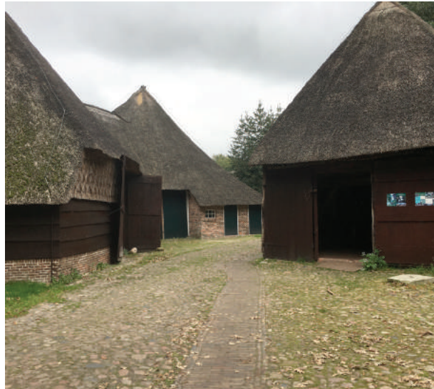
De informele opbouw van de erven met (houten) schuren aan de weg is zeer waardevol.
