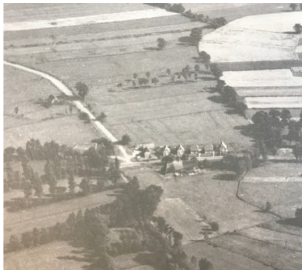
Zicht op de Brugstraat vanuit het noorden met in het midden achter de boerderij het rijtje wederopbouwoningen van vlak na WO II. (bron: RCE).
