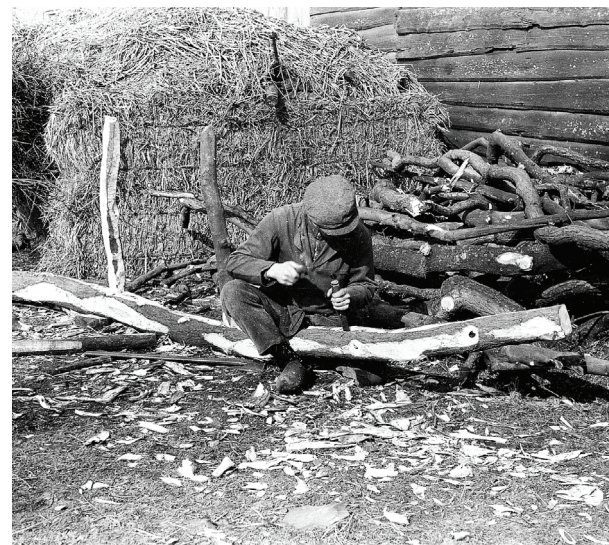
Het handmatig bewerken van houten stammen voor de bouw van onder andere hekwerken. Serie van Beelen 1944 (bron: coll. NL).
