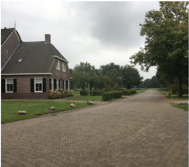
Beeldbepalende boerderij aan de Brugstraat 21 bij de aansluiting op De Wiet.
